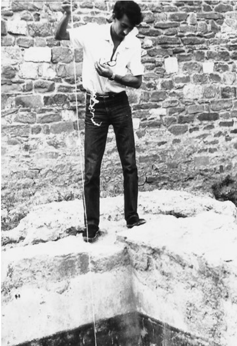
Maurizio al lavoro nei cantieri di restauro della Rocca Aldobrandesca di Scarlino in provincia di Grosseto, nel 1982.
