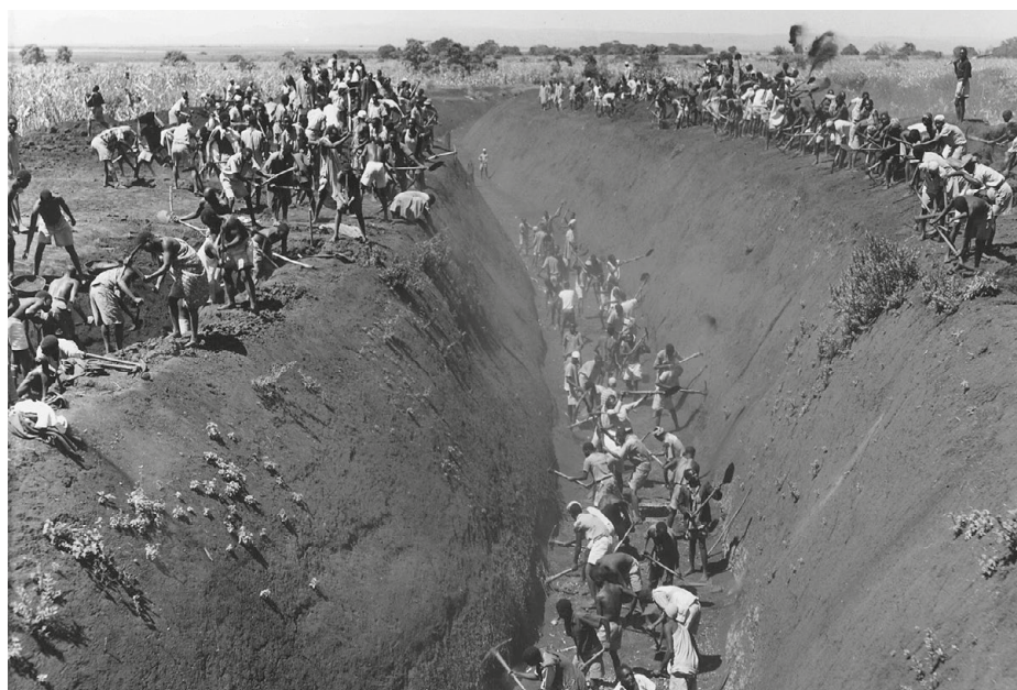
36. Kenya, rivolta dei Mau Mau, 1957. Campo di internati civili: scavo di un canale.
